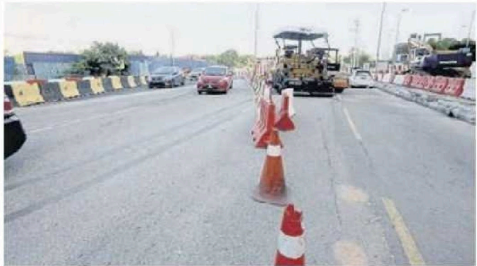
冼都巴刹路依然保持4条车道，减少工程期间的交通冲击。
