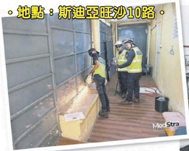
■官员在拆除业者违例扩建的建筑。
