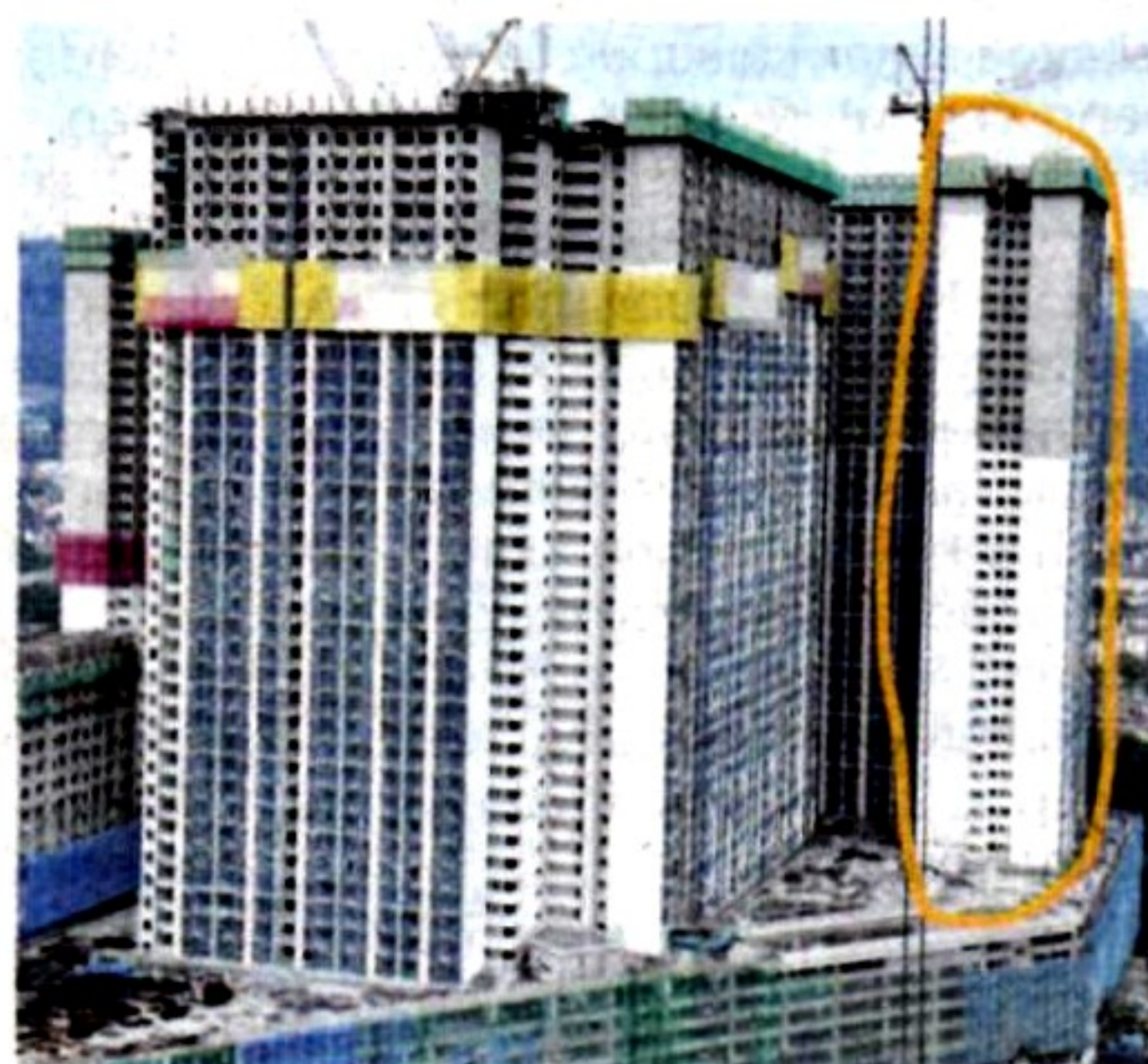
Siasatan tapak telah dijalankan oleh DBKL dan mendapati terdapat keretakan pada struktur dinding, tiang dan lantai pada unit-unit yang berada di tingkat lapan dan ke atas.
