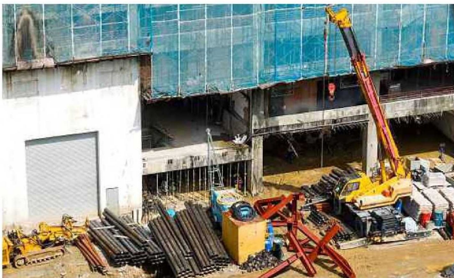
TINJAUAN punca masalah kesihatan penduduk akibat pembinaan pangsapuri baru di kawasan berhampiran pintu masuk di PPR Wangsa Sari. - Gambar NSTP/NABILA ADLINA AZAHARI
