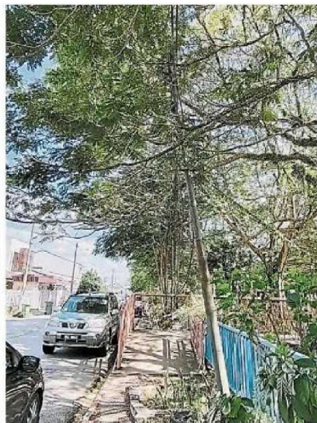
几乎倒下，情况骇人。竹树未清理之前，树枝压向灯柱电线，整根电柱
