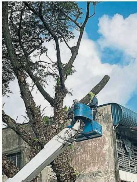
承包商已开工修剪树木，包括遮挡在屋顶及马路上方的枝桠。（陈佩莉摄）
