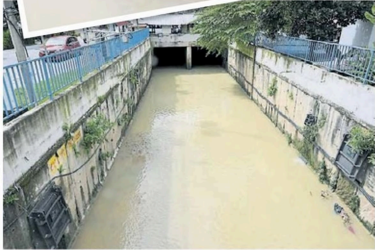
■ 市政局于今年中加高了沟渠围墙。
