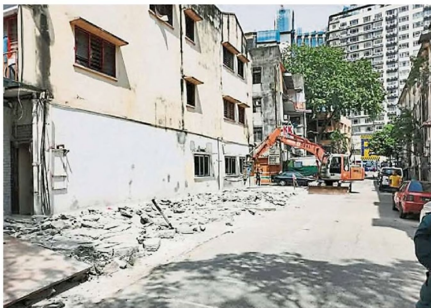
吉隆坡市政局在武吉免登多个街道展开执法行动，拆除非法扩建结构。（黎正兴提供）
