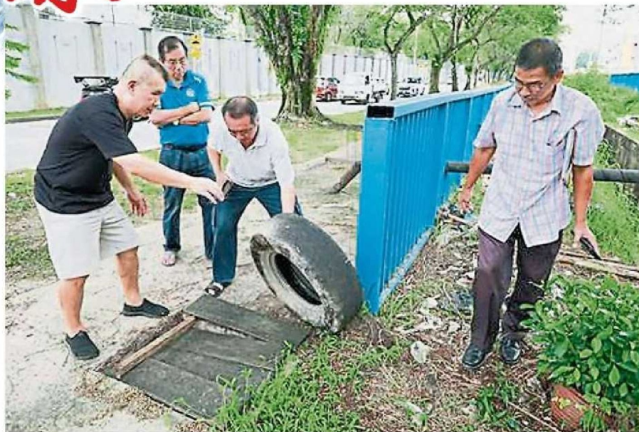
居民揭開覆蓋溝渠洞口上面的廢棄輪胎，視察地下情況，發現內部排水孔竟然被關閉，右為余保凭。（黃玲玲攝）
