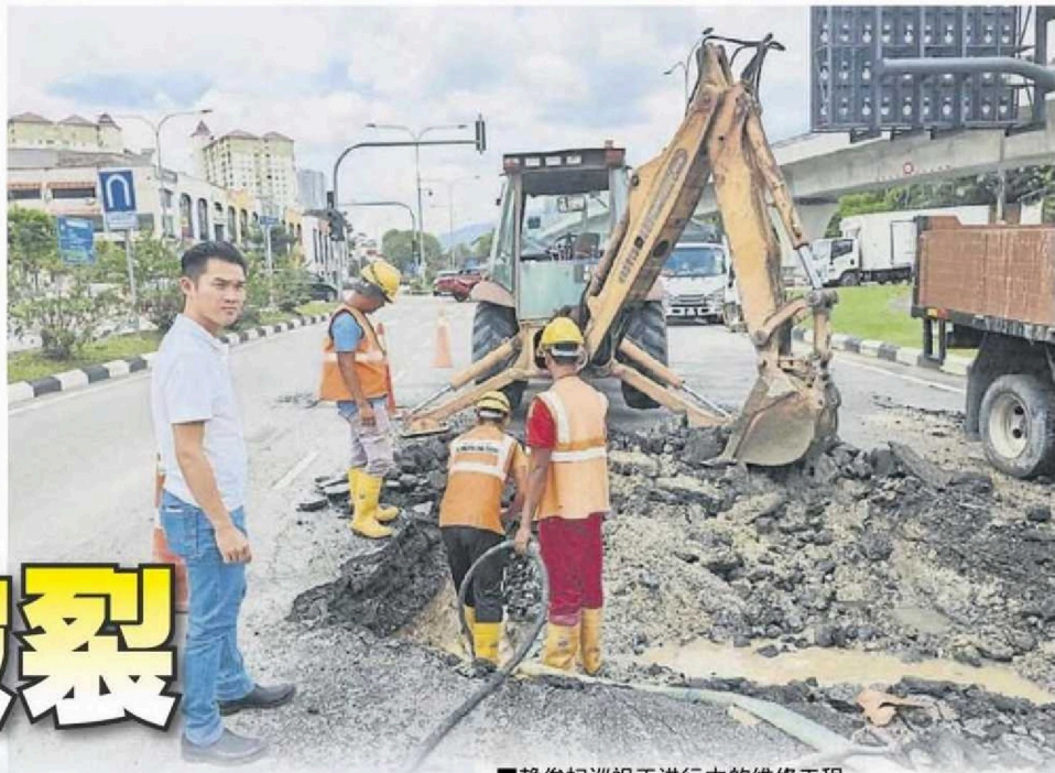
■赖俊权巡视正进行中的维修工程。
