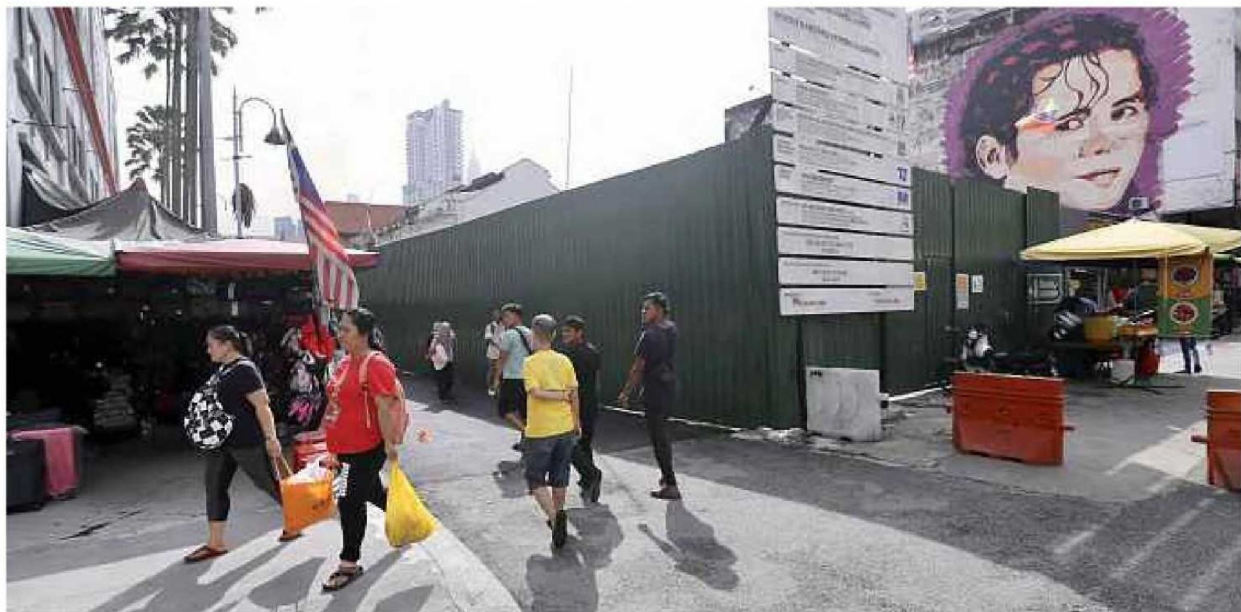
GERAI di Jalan Lorong Muhibbah yang dirobohkan oleh DBKL pada April lalu dikepong untuk pembinaan baharu. - Gambar NSTP/FATHIL ASRI
