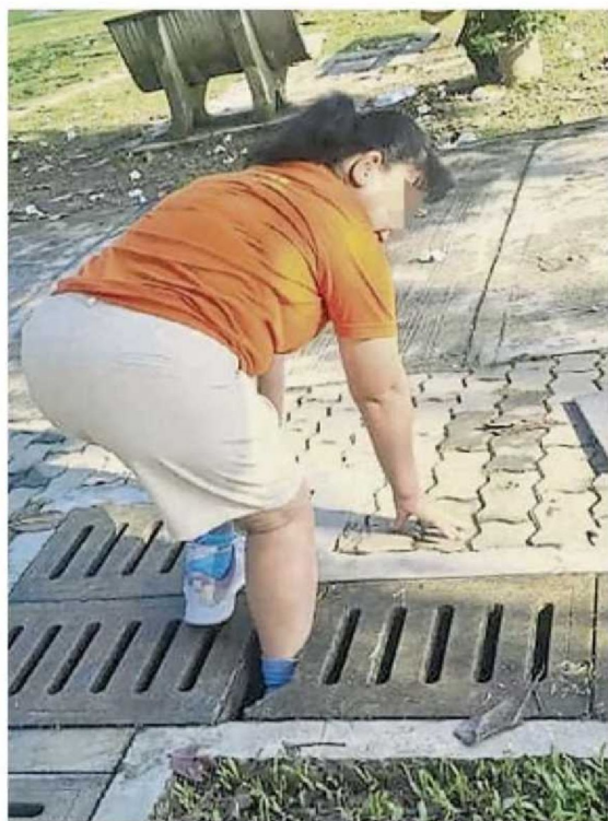
■一名婦女晨運時，不慎踩到損壞的溝渠蓋。
