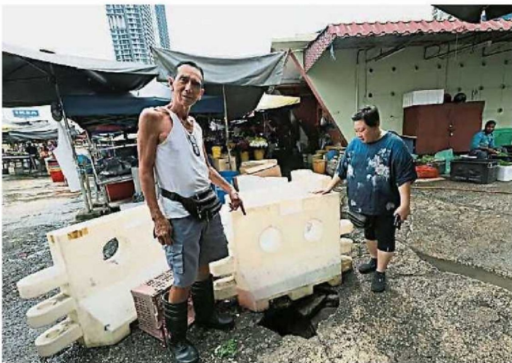
林钦喜（左）表示，巴剎范围的沟渠陆续出现坍塌情况，小販们只能在坍塌处置放障碍物，避免民众不慎踩空而受伤，右为蔡美丽。
