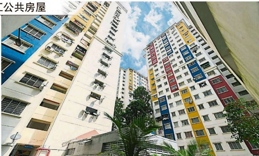
文良港帝沙惹江公共房屋此前面对电梯长期故障问题。（取自吉隆坡市政局脸书）
