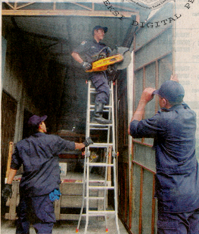
PENGUAT kuasa DBKL meruntuhkan sambungan haram yang dibina pada salah satu premis kedai di dalam operasi di Pusat Bandar Utara, Selayang, semalam. – UTUSAN/MOHD. SAIFUDIN RASHID
