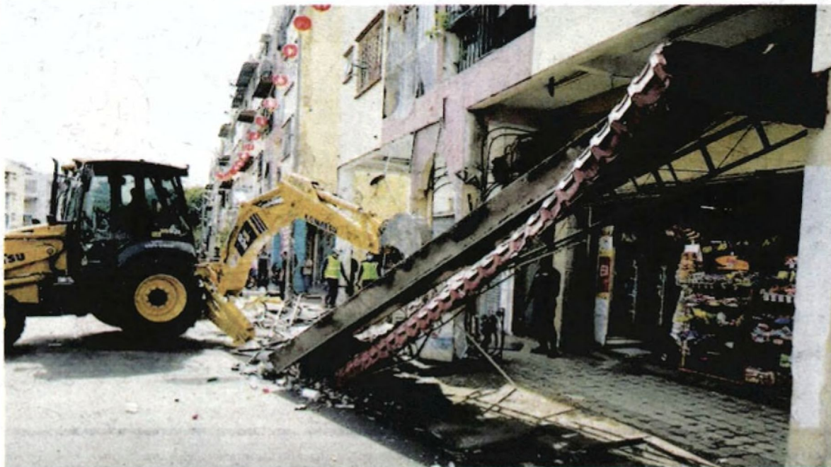
DBKL meroboh struktur haram di rezab jalan awam di sekitar Segambut, Kuala Lumpur kelmarin.
