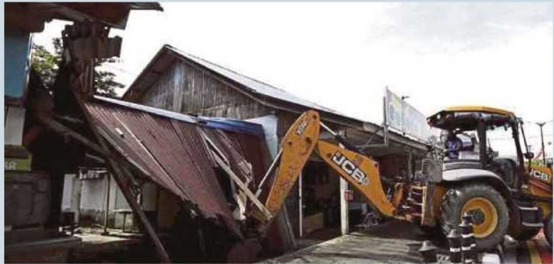
Jentera meroboh struktur yang dibina di atas rizab jalan awam dalam operasi bersepadu DBKL di sekitar Bandar Tun Razak, Kuala Lumpur, Rabu lalu.
