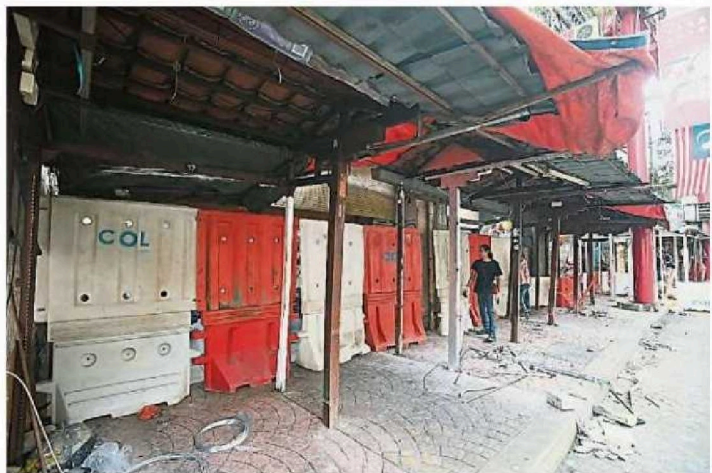
为了安全起见，商店与摊位之间设置路障作为隔离，避免施工期间有民众误入工地，以确保人们的安全。(黄冰冰摄)
