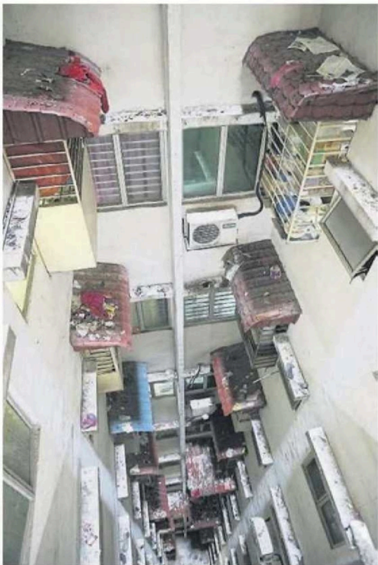
一些居民从高楼丢垃圾下楼，部分垃圾落在遮雨棚上。
