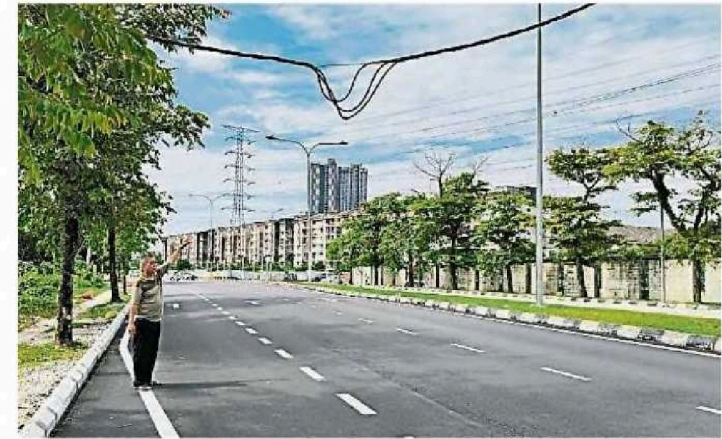
周先生说,电线疑似被施工挖土机勾到而垂了下来,相当危险。
