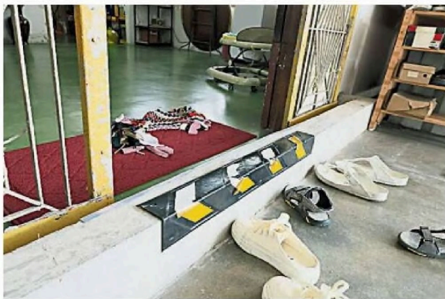
居民在家门前构建挡水墙, 防止积水涌入家内。
