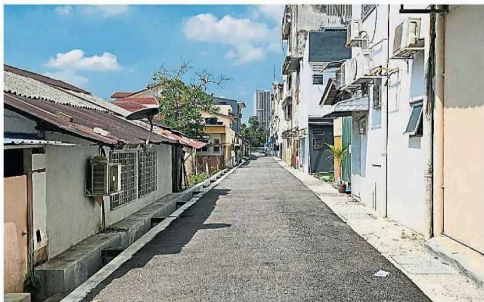
赖俊权表示，在增江乌达玛路第一阶段工程拆除店家违建设施后，该区后巷已恢复足以车辆正常通行的宽敞度了。（黄国强摄）
