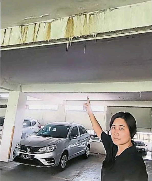
▼梁愛君巡視停車場時發現，牆體懸掛着看似鐘乳石的水滴固體狀物，顏色污濁。
