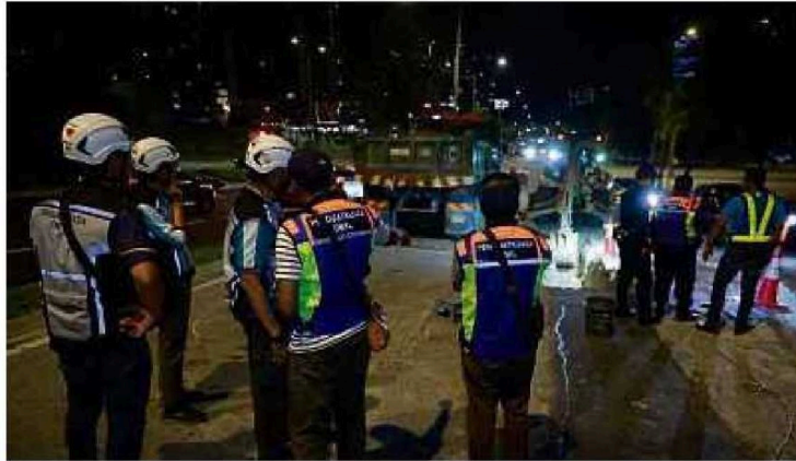
Antara lokasi kerja mengorek jalan oleh kontraktor yang diperiksa DBKL dan CIDB di ibu negara.
