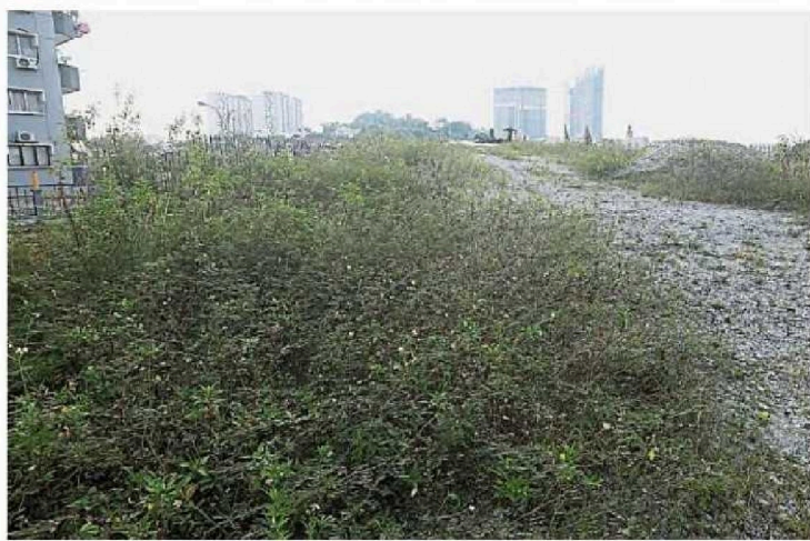
高架天桥工程处杂草丛生，明显已久未动工。
