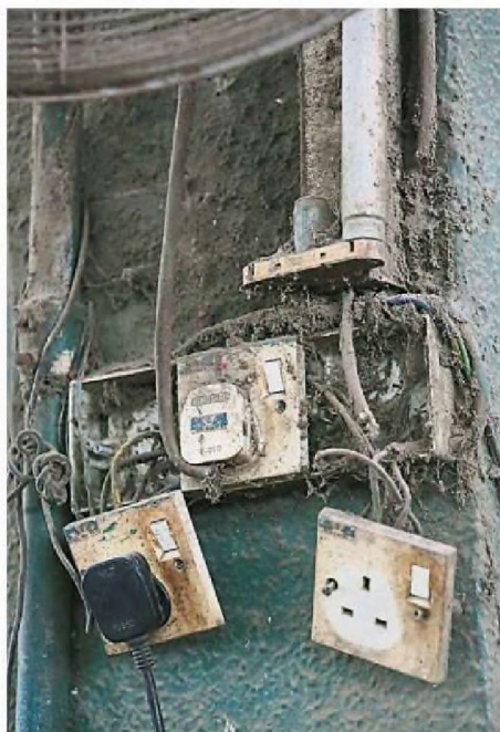
損壞了的電插座沒有維修及更換掉, 但卻仍舊照用不誤, 相當危險。
