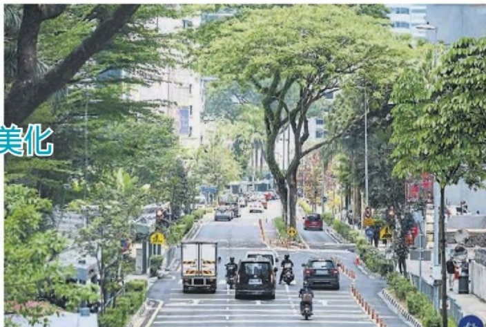
■市政局配合东盟峰会到来，在霹雳路展开铺路工程。
