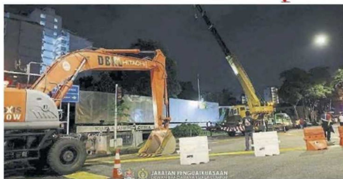
■市政局20日晚上，到班底谷展开拆除违规广告框架行动。
