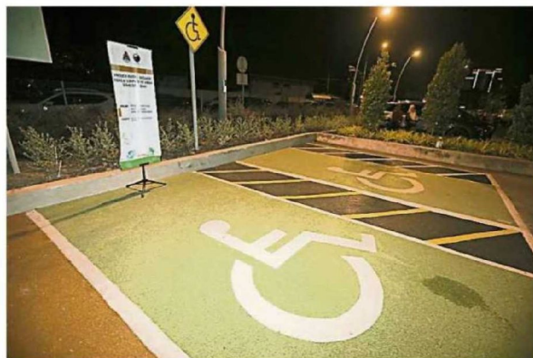
残障人士停车位上铺上一层是玻璃废料涂层，成为全新的创新环保概念。（黄志汉摄）
