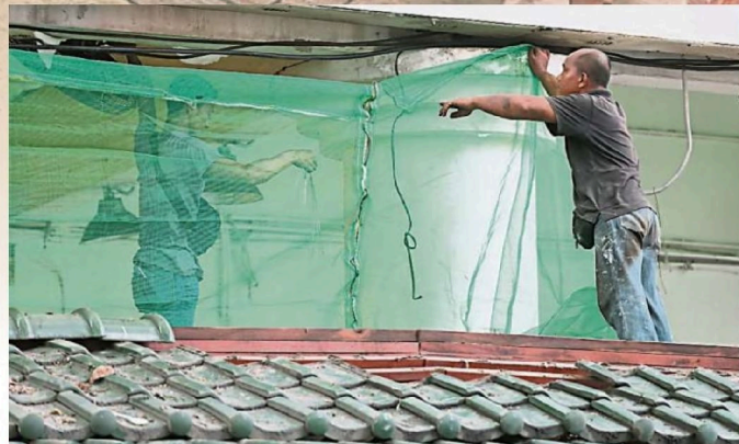
↑兩名工人在施工範圍附近的建築外牆安裝綠色防護網，以保障施工安全並減少灰塵四散。
