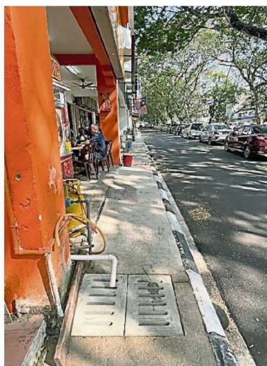
商店前的沟渠获得提升，现已焕然一新。
