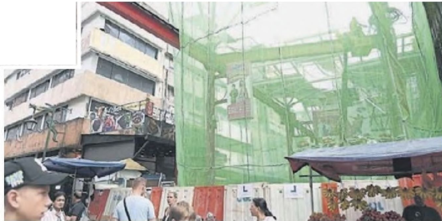
■茨厂街迈入第2阶段美化工程，主要是修缮遮阳顶及安装小贩摊位电表，一切进展顺利。
