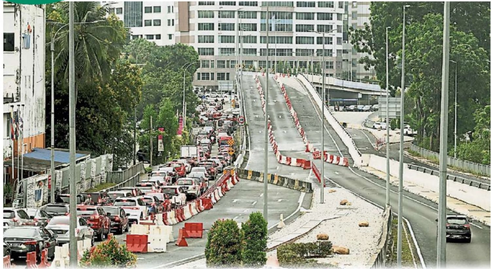
柏林京路往士曼丹路的高架天桥暂时封锁，导致车辆涌入支路，形成严重的交通瓶颈。（星报照片）
