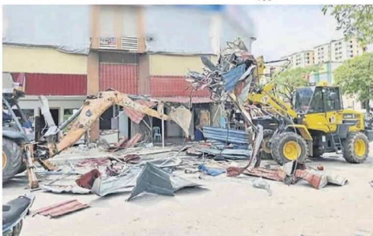
■市政局出动挖泥机，拆除美食中心违建的遮棚。
