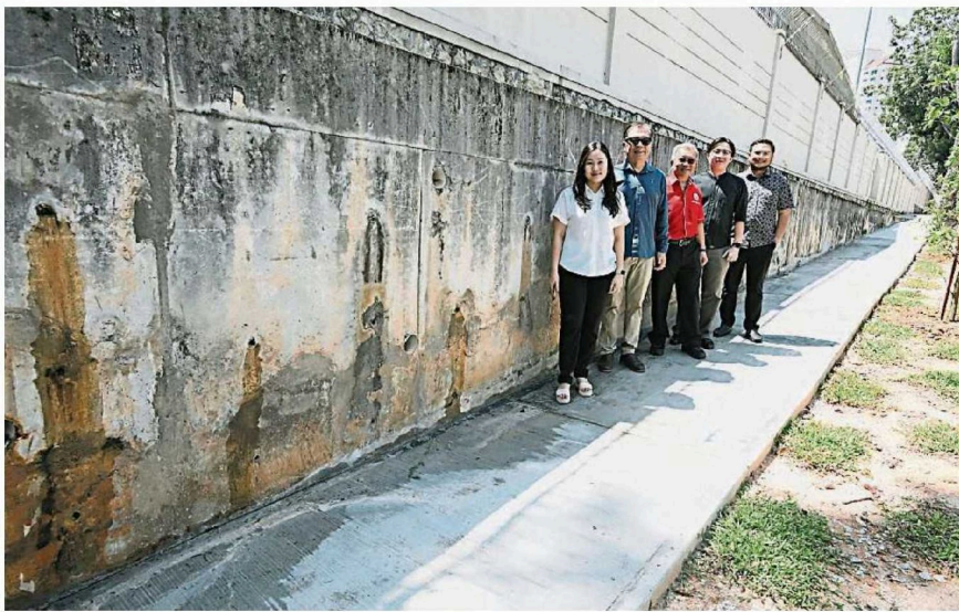
叶依雯（左起）、颜金福、叶乔强、肖恩及王忠义前往巡视已完工的行人道。
